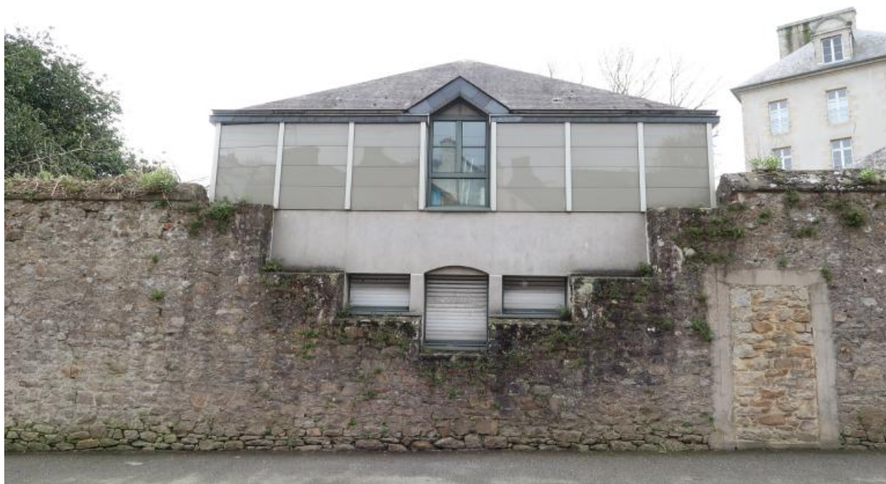
Logement de fonction vu depuis la rue.
