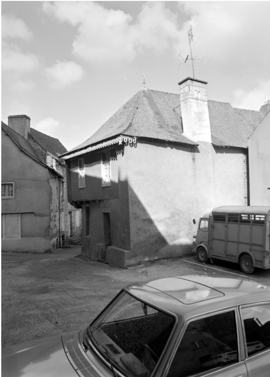
Maison, 9 Carrefour Saint-Gurval, vue générale sud-est.
