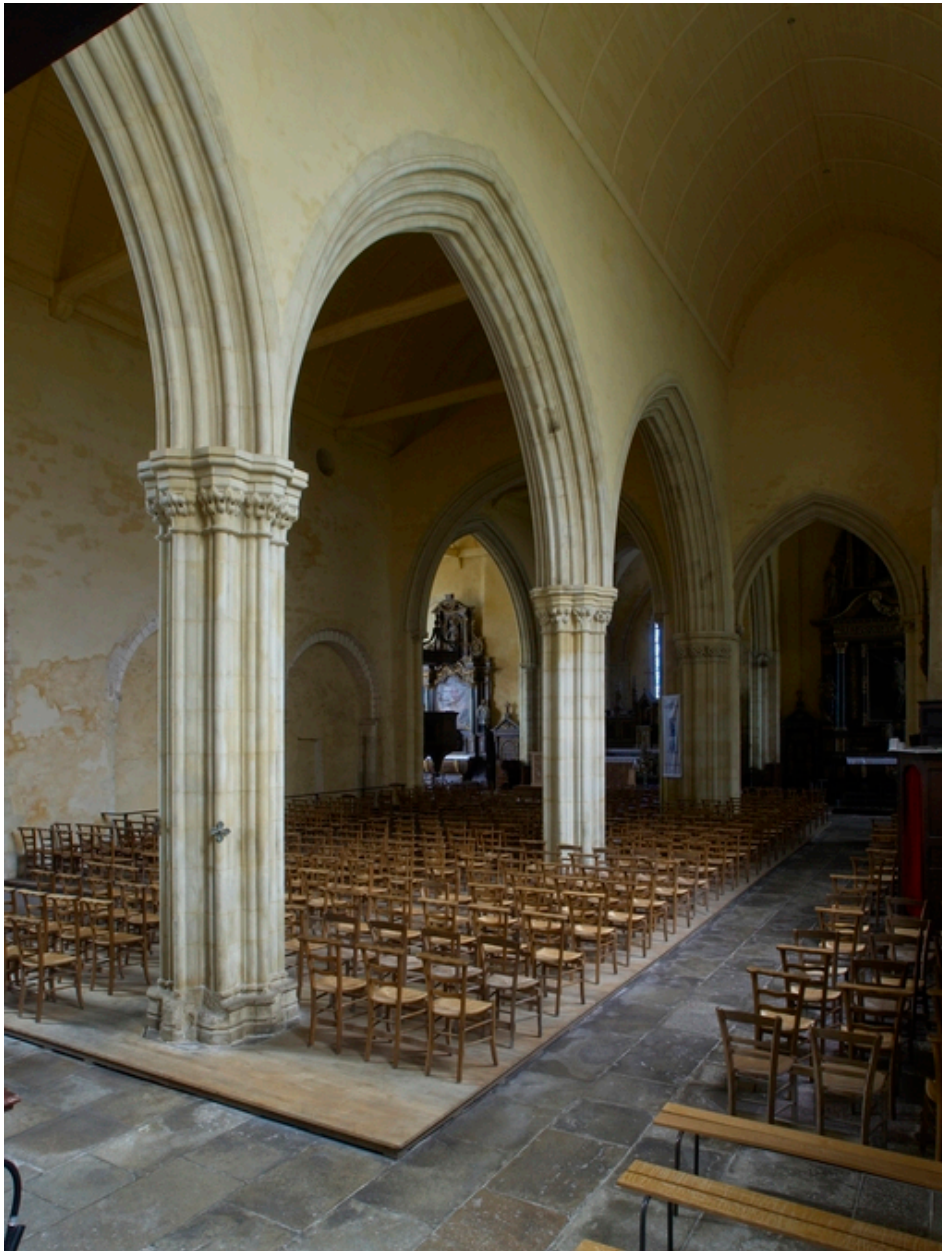
Vue de la nef de l'ancien choeur vers le collatéral sud
