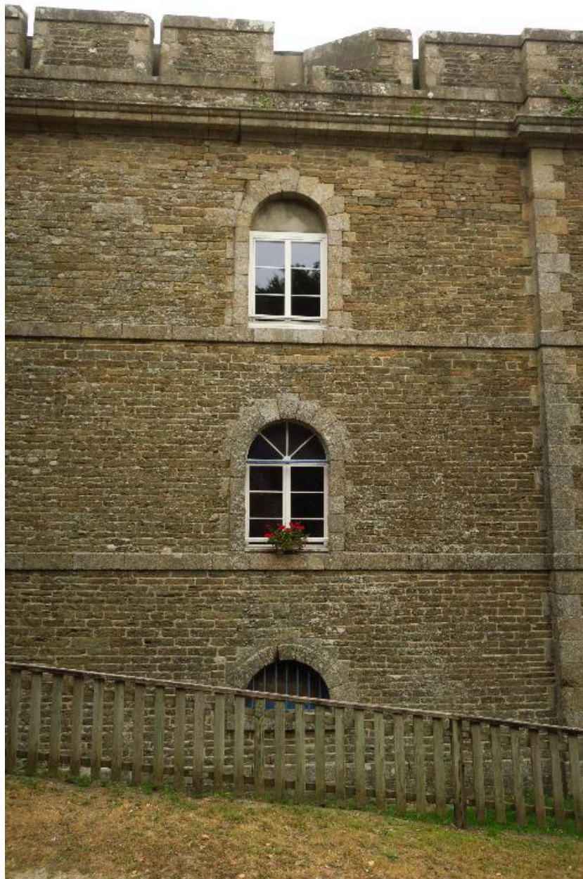
Groix, fort dit Fort Surville, caserne à l'épreuve.
