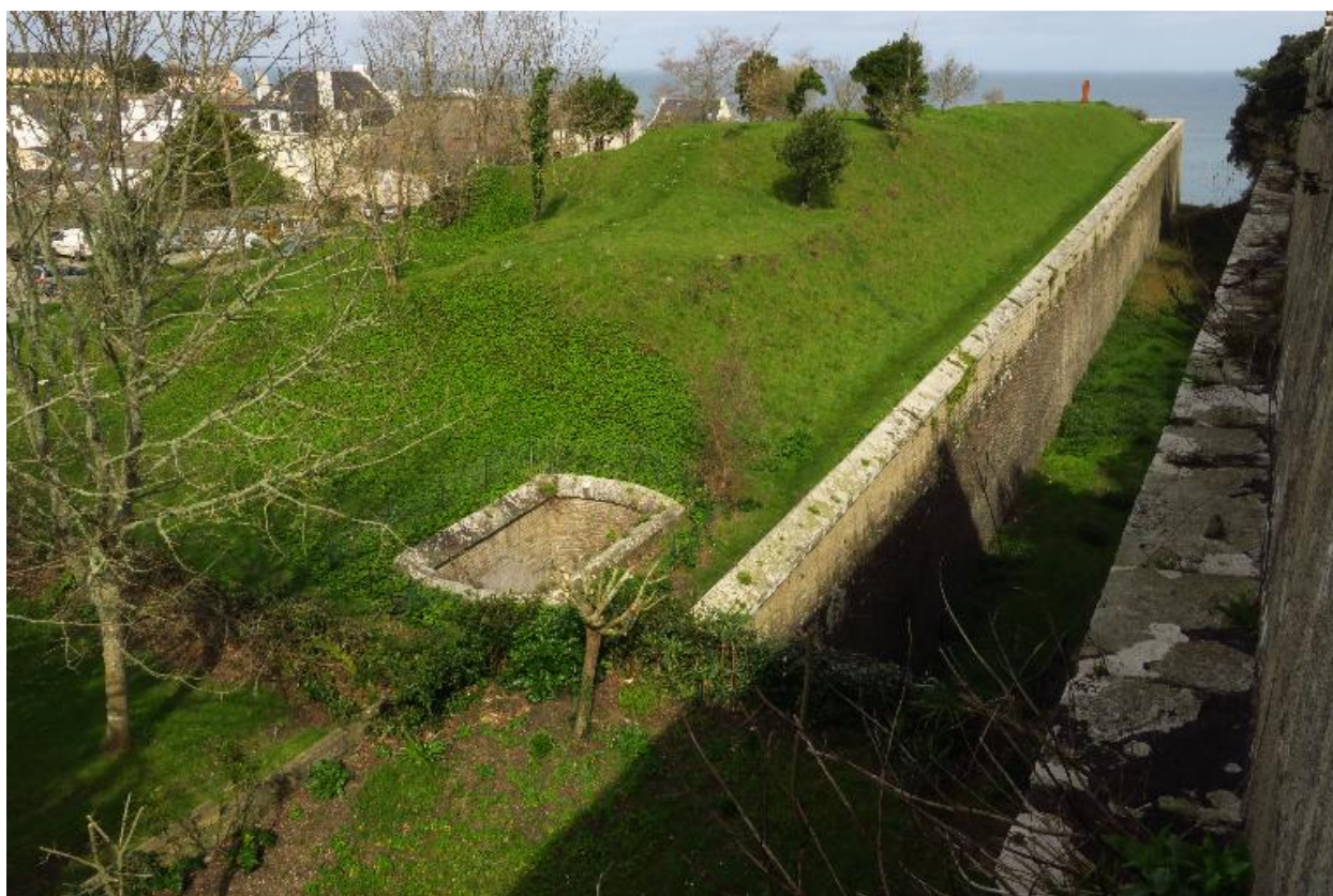
Le Palais, enceinte urbaine, courtine 18, vue d'ensemble depuis le réduit A.
