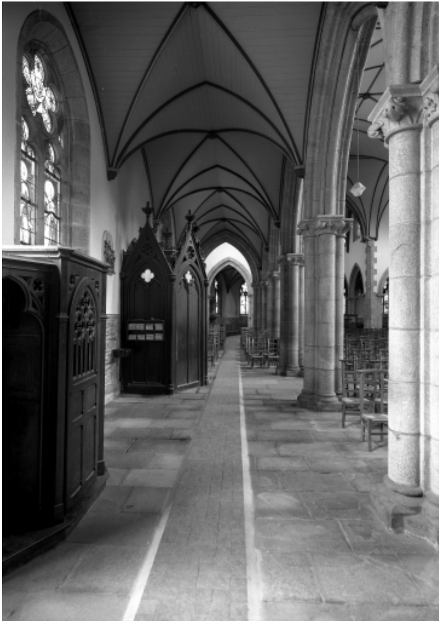
Châteaulin, église paroissiale Saint-Idunet : collatéral nord, vue axiale vers l'est, état en 1972
