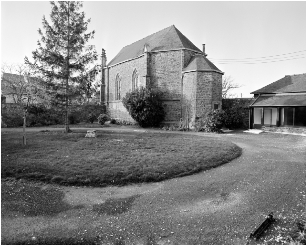
Elévation sud-est, chevet : vue générale
