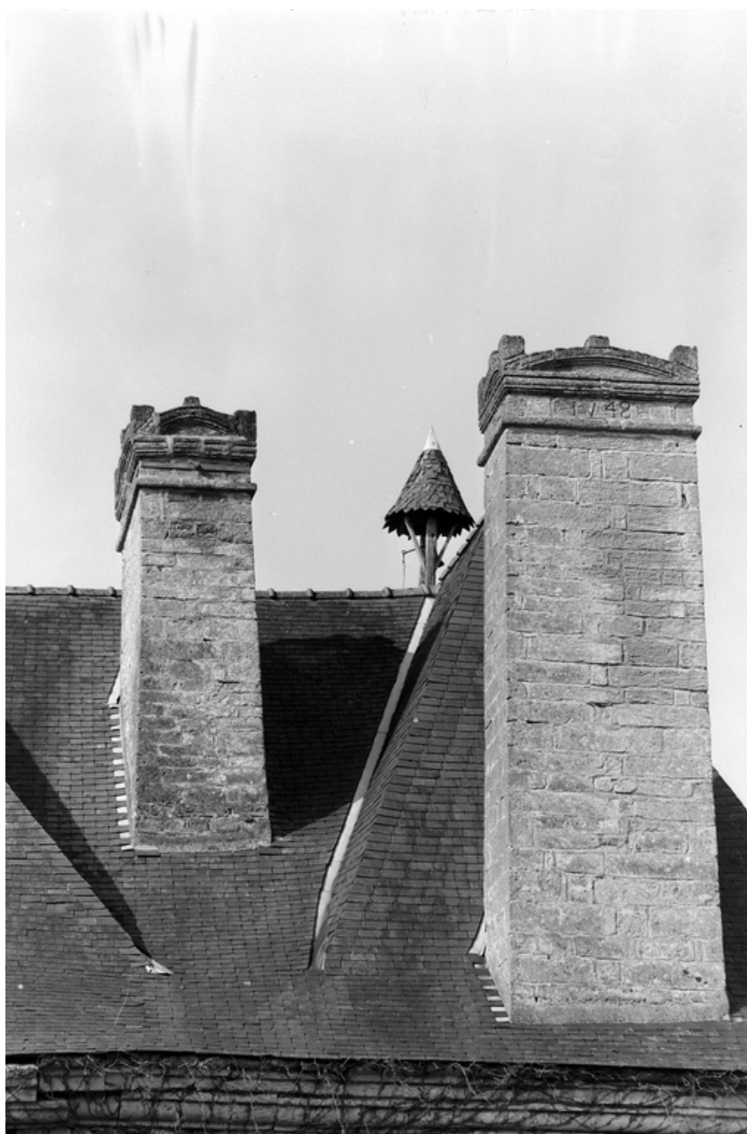
Pavillon d'angle : détail souches de cheminée
