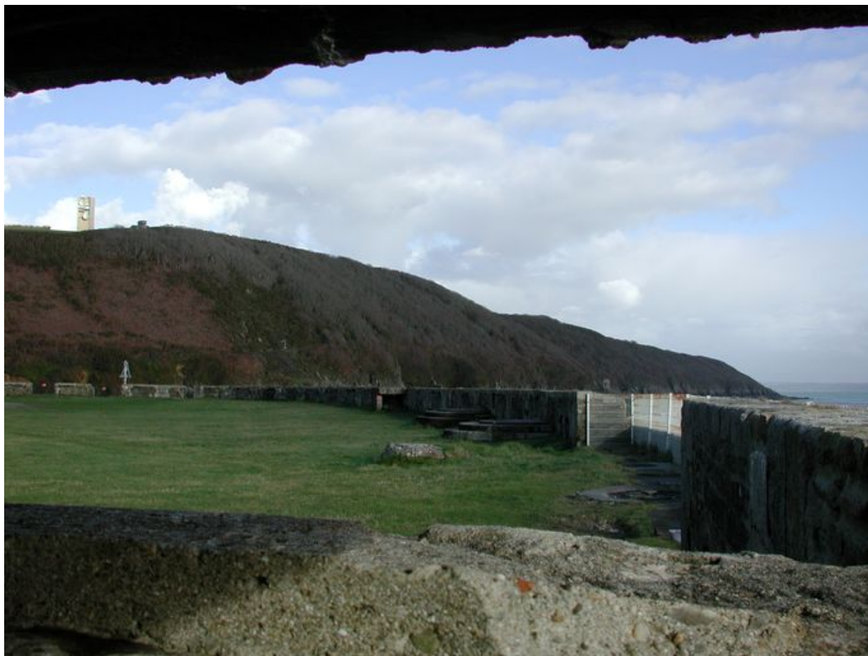
Vue du fort du Mengant : plate-forme de la batterie basse depuis l'abri bétonné
