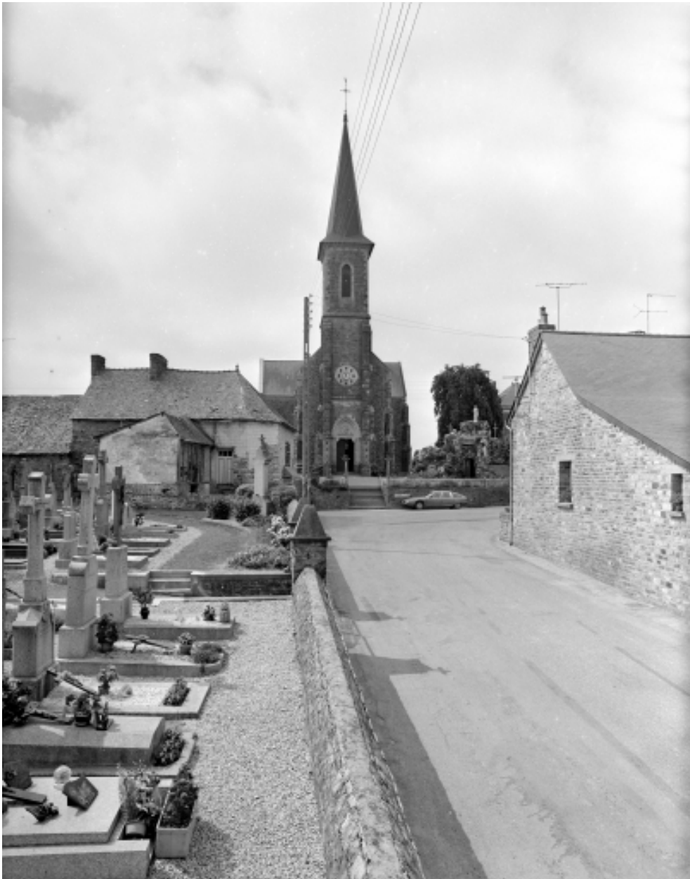
Vue générale prise du nord.
