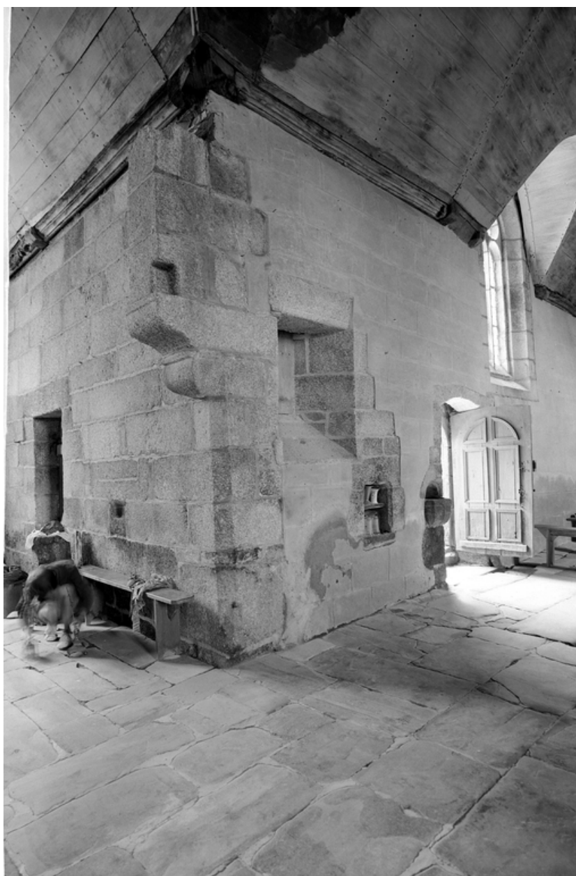
Croisée du transept : angle sud ouest
