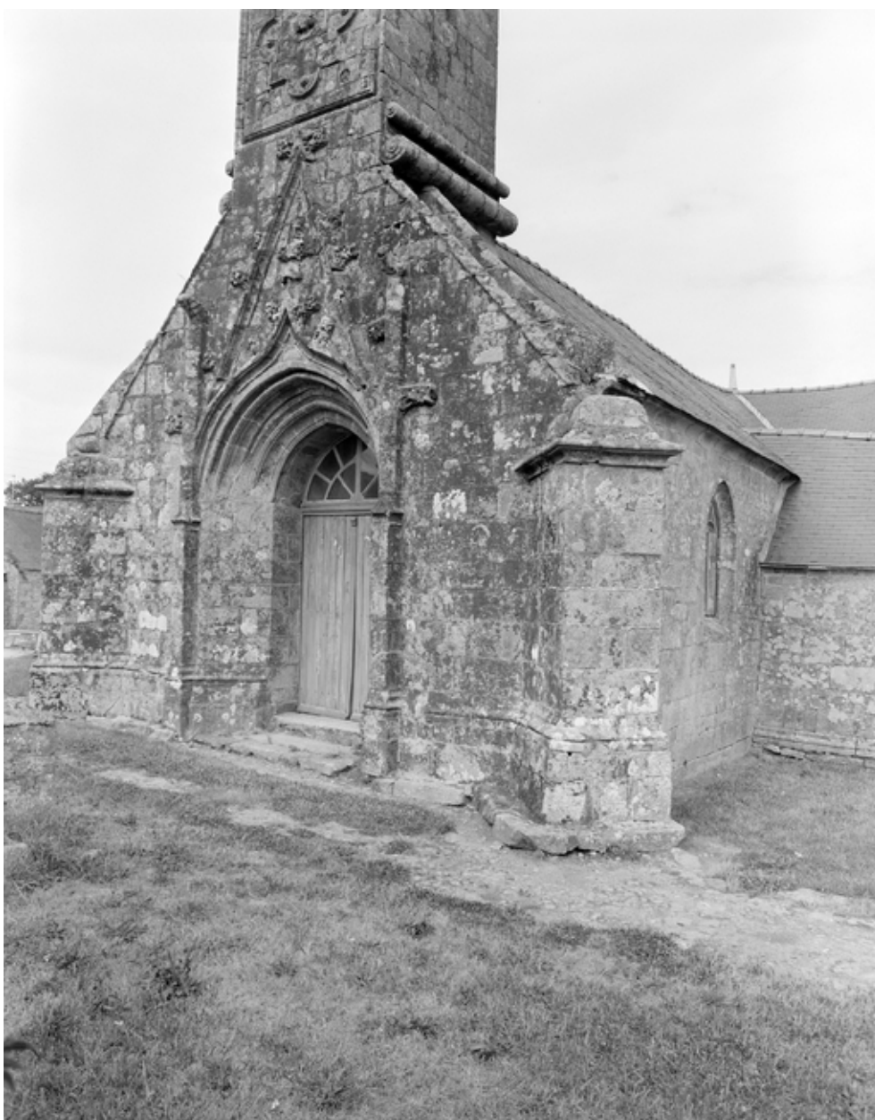
Vue de la façade ouest
