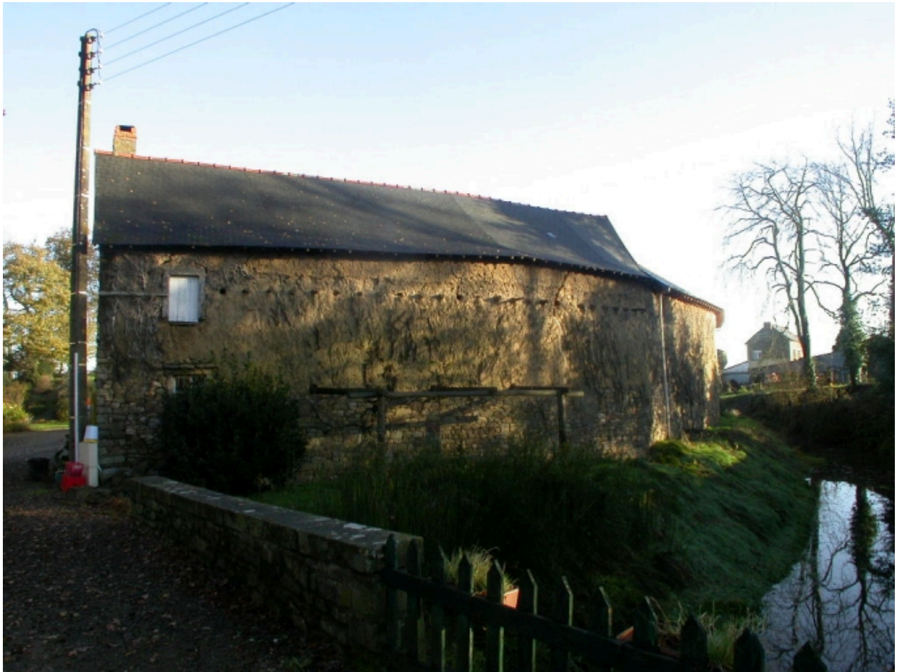
Façade postérieure des dépendances
