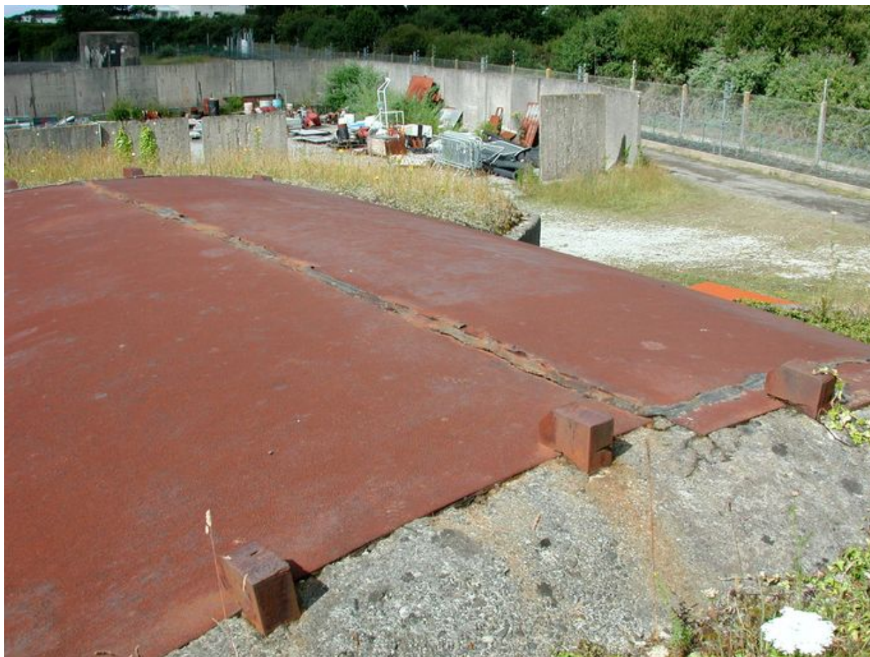
Vue du toit blindé (état en 2003)
