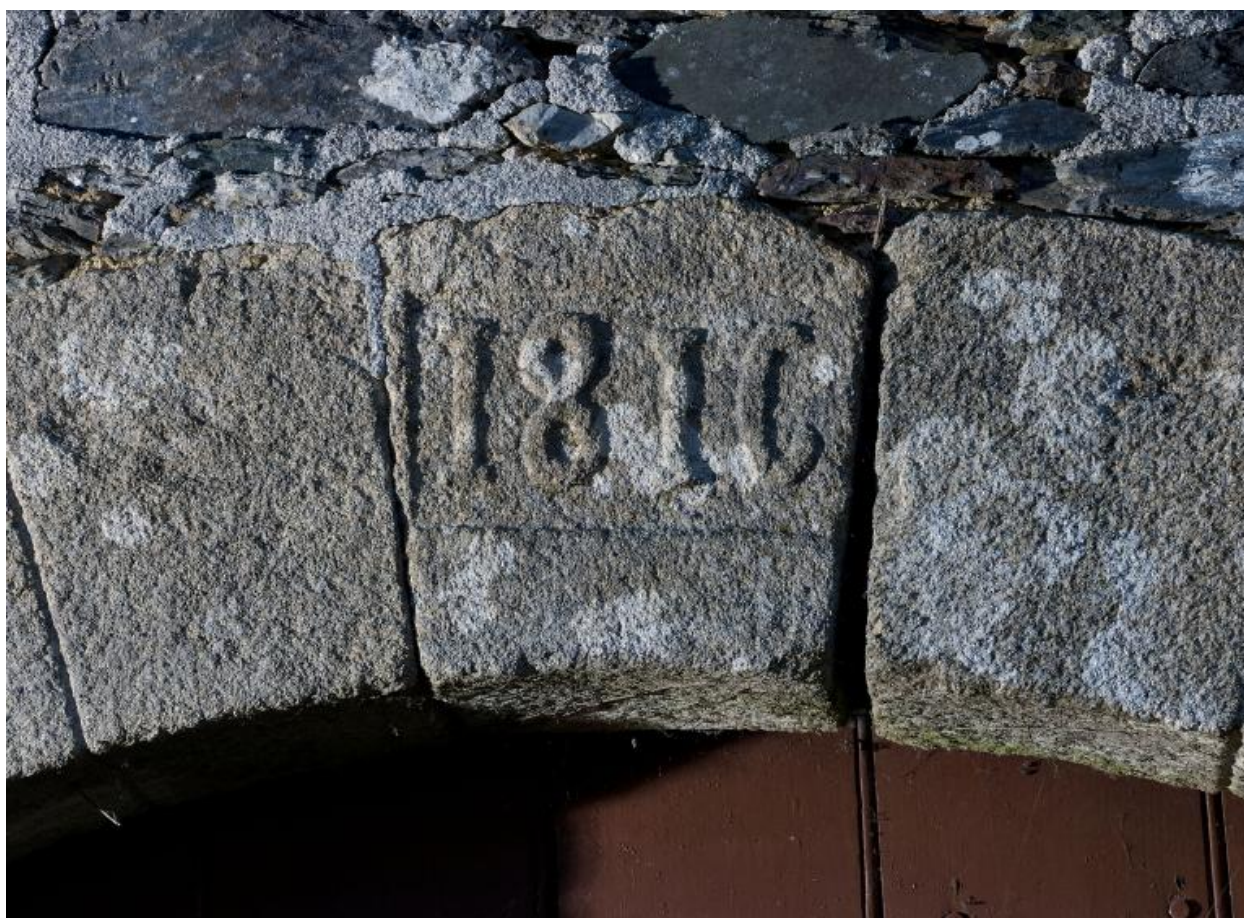
Dépendance ouest. Détail de la date sur la porte : 1810
