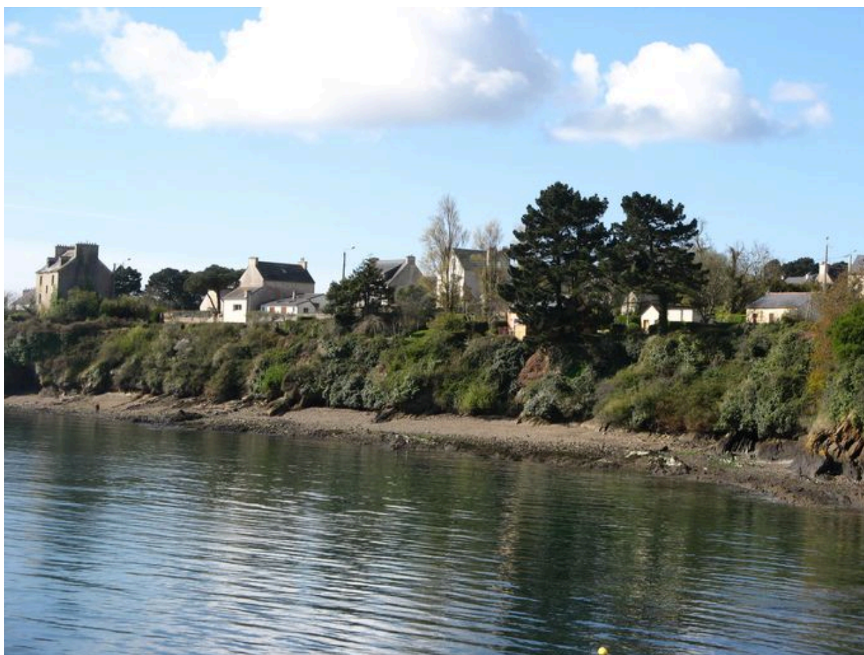
Vue générale du front de mer résidentiel de Roscanvel, entre le bourg et Pont-Scorff
