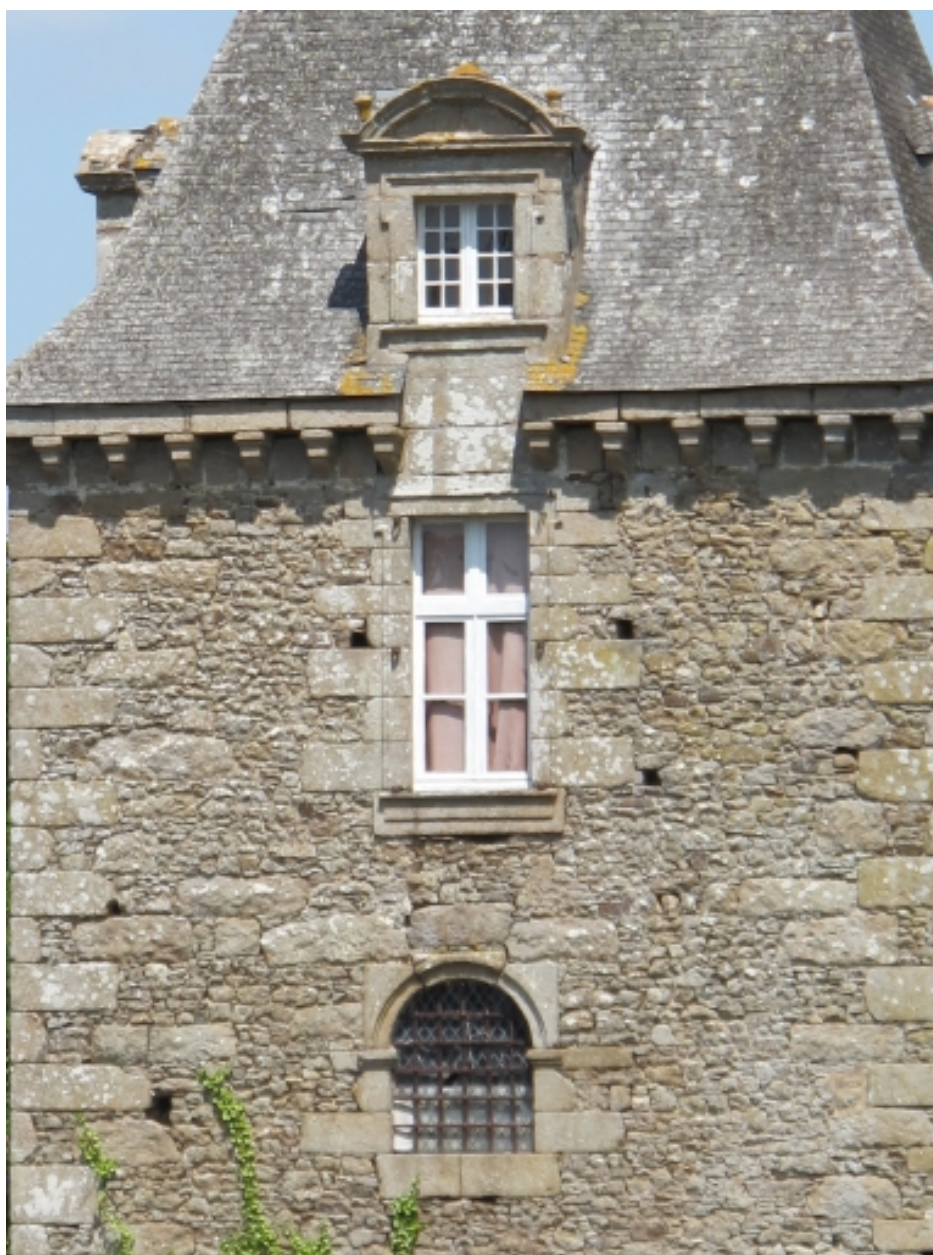
Détail du pavillon nord-ouest, baie de la chapelle
