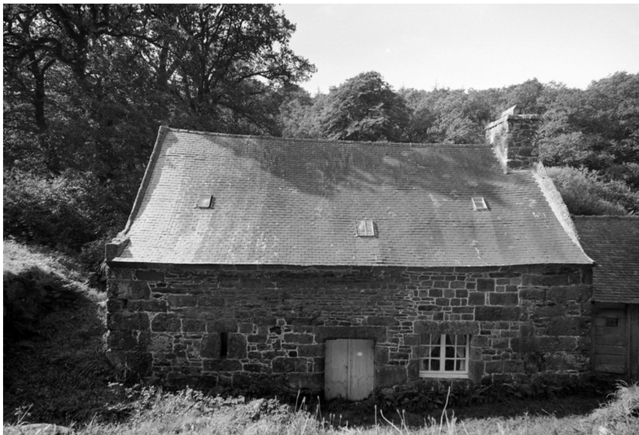
Moulin : façade est
