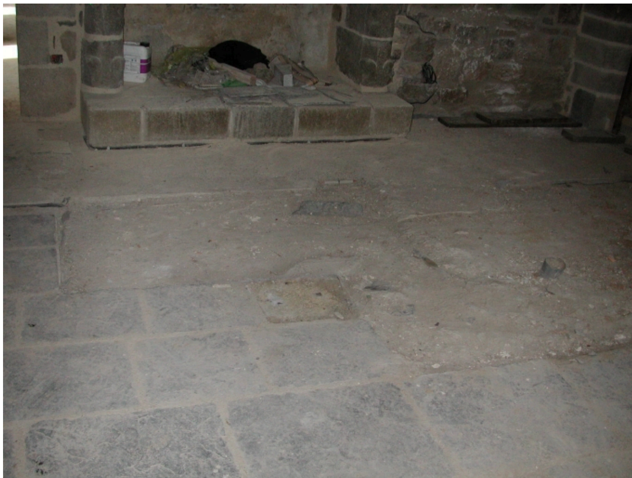
Vue du sol dallé en schiste dans les pièces des bâtiments
