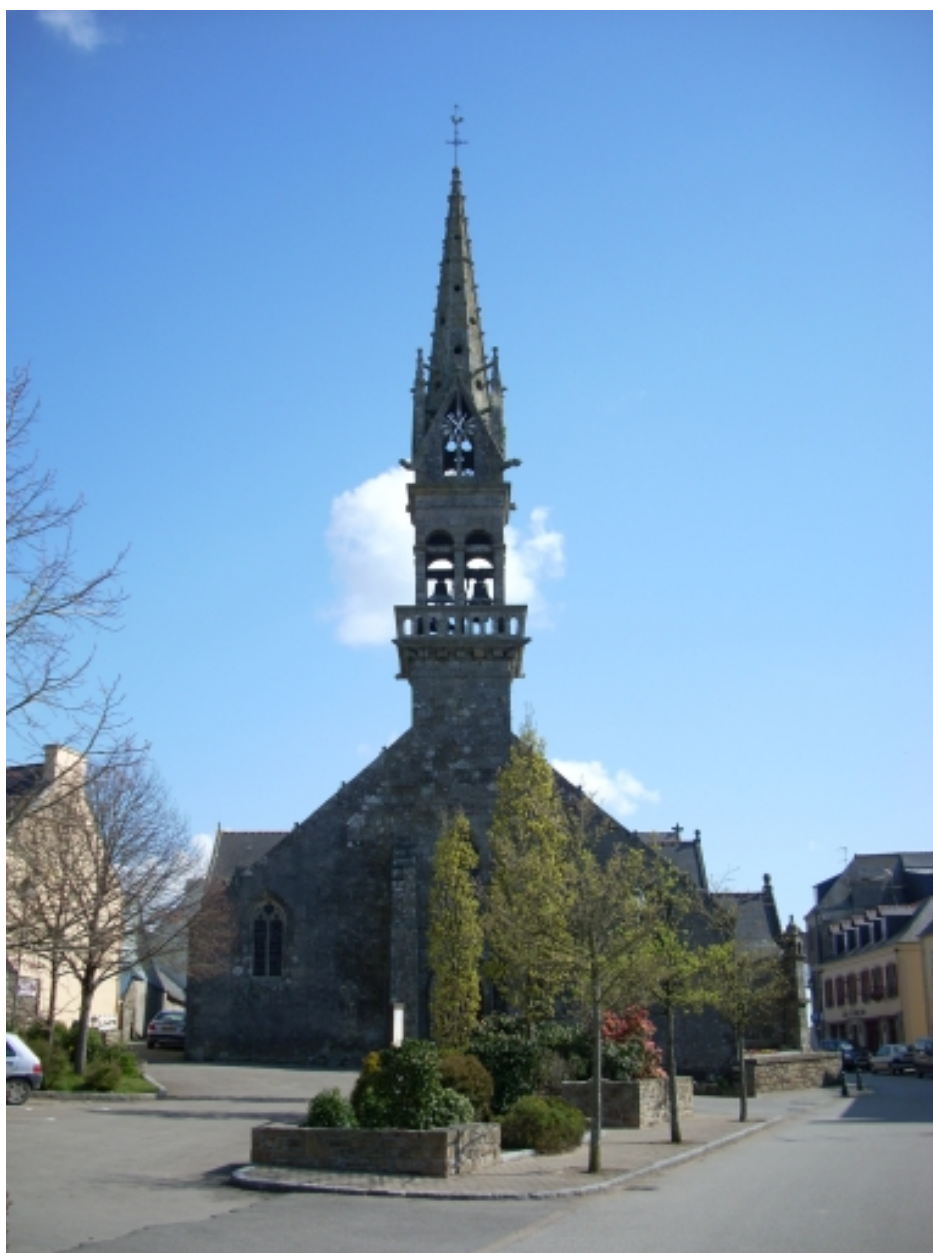
Plomodiern, église paroissiale Saint-Mahouarn : élévation ouest
