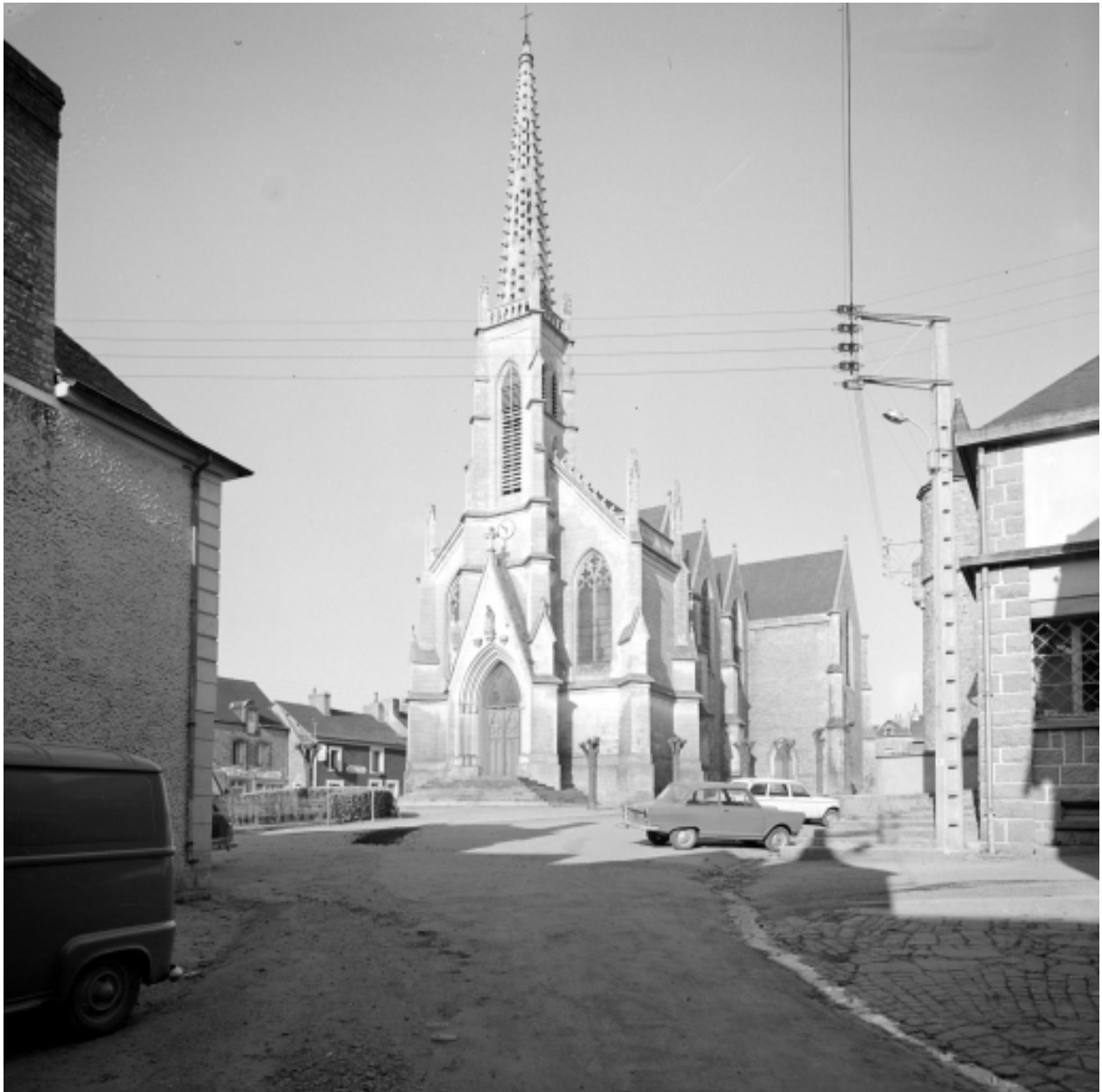
Elévation ouest : vue générale
