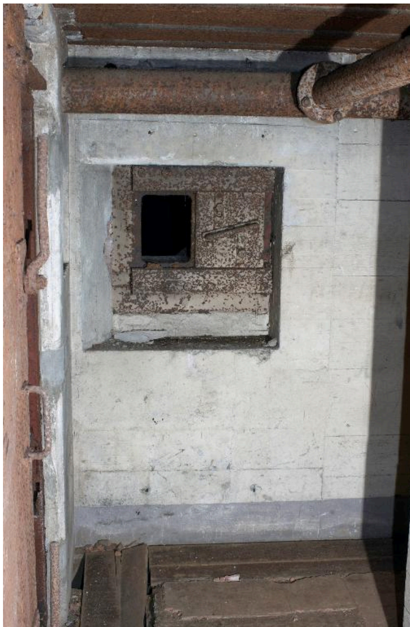
Vue intérieure : créneau blindé de défense (état en 2009)
