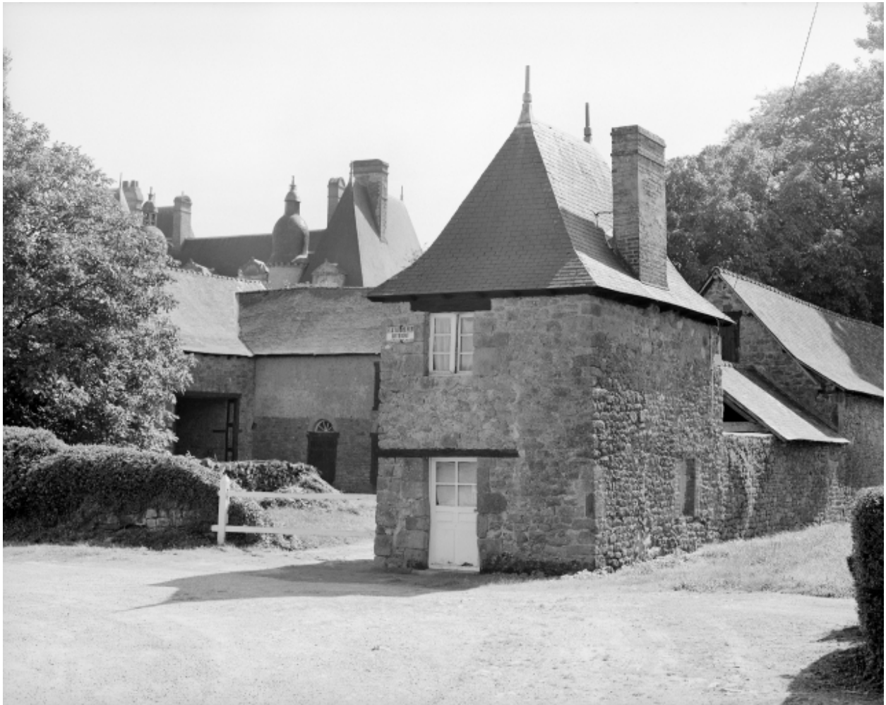
Ferme, pavillon dans l'angle nord-ouest, vue générale.
