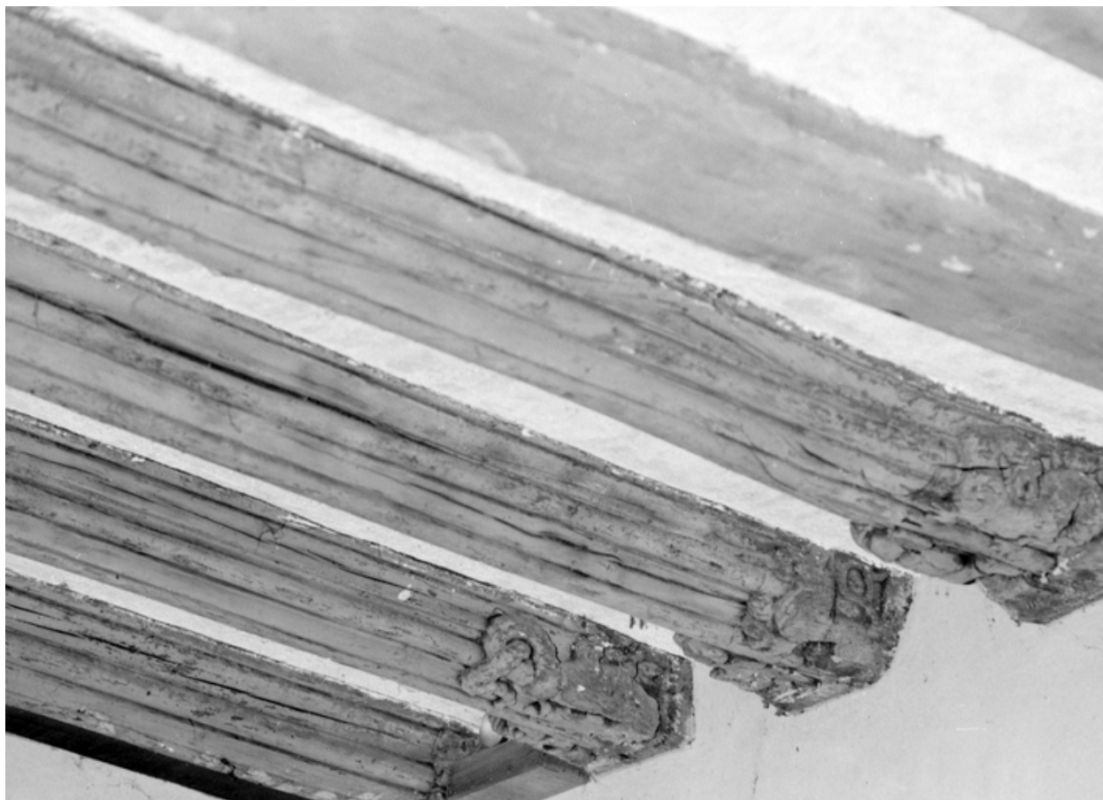
Tour sud, poutres moulurées : vue générale (état en 1984)
