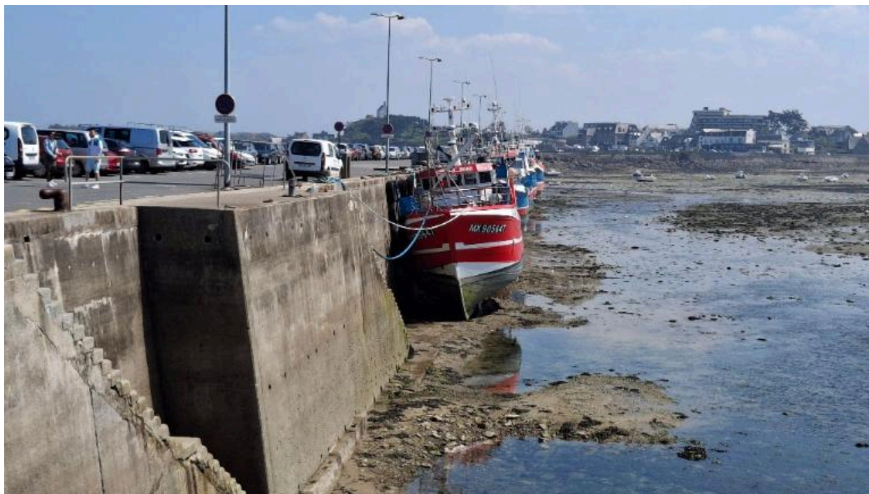
Le quai neuf : mur de quai en béton
