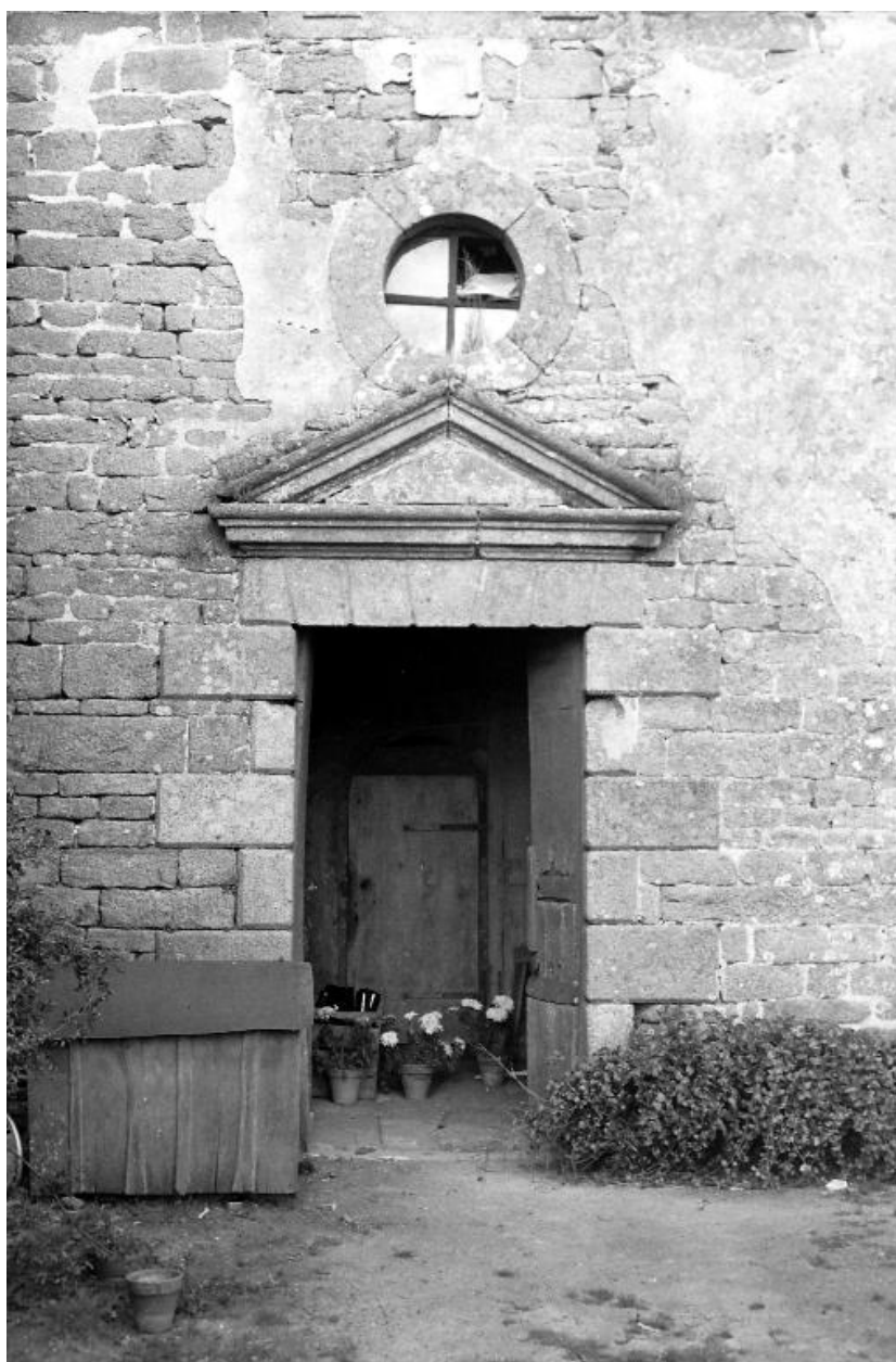
Porte de la façade sud ouest
