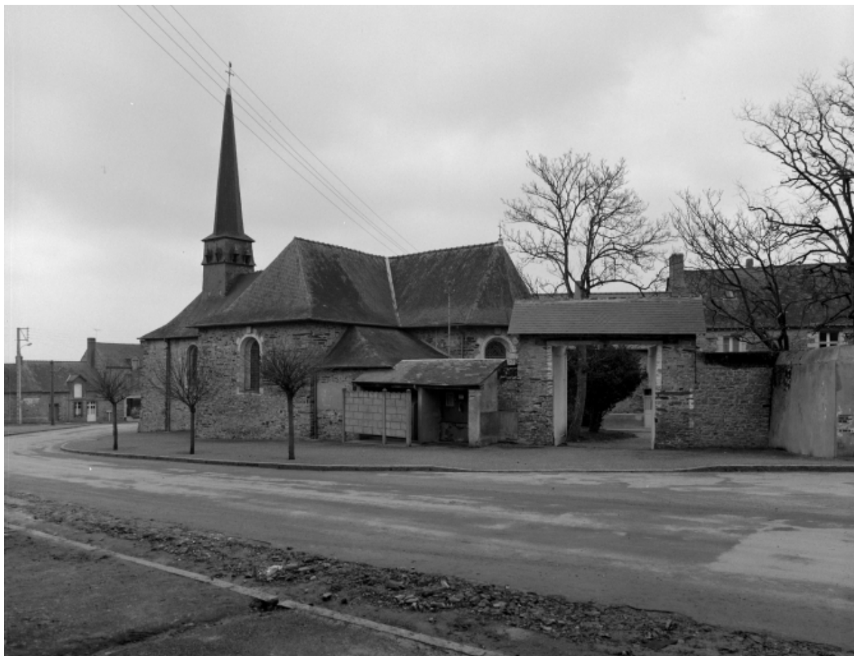
Elévation sud-est : vue générale
