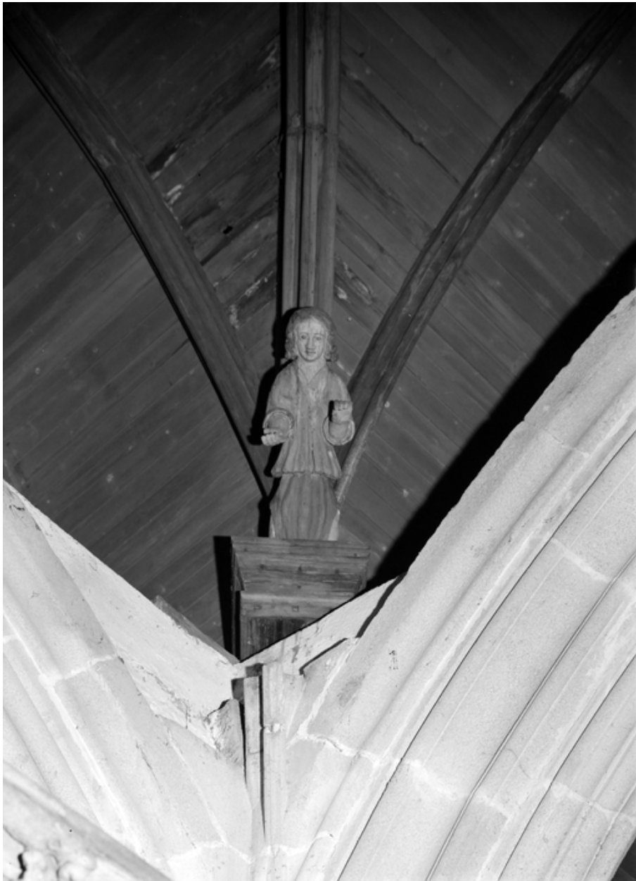
Croisée du transept, lambris corbelet nord-ouest.
