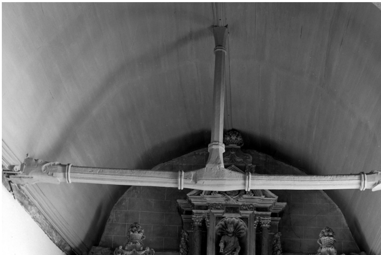
Intérieur, nef, charpente : vue générale.
