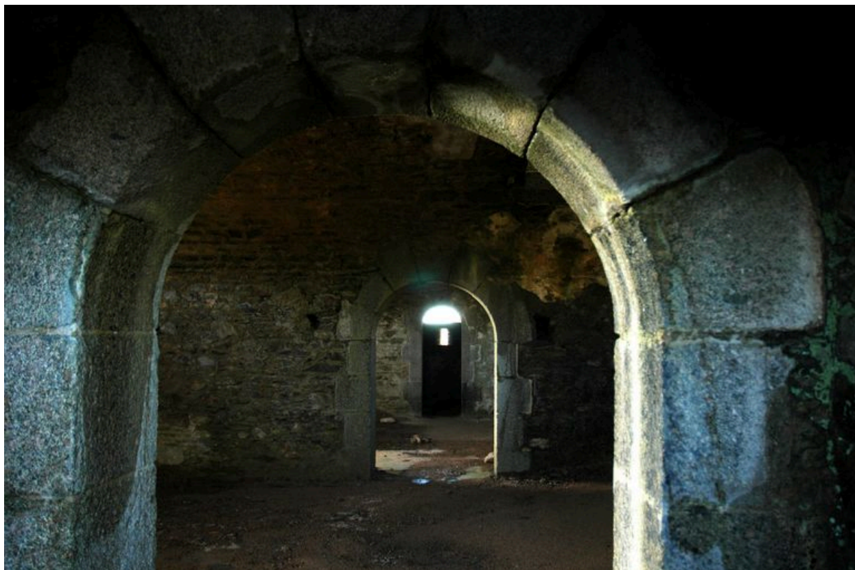
Vue de l'intérieur du réduit à travers la grille
