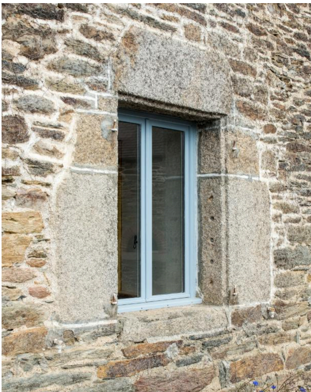
Logis est, élévation sud-est, vue générale d'une ouverture
