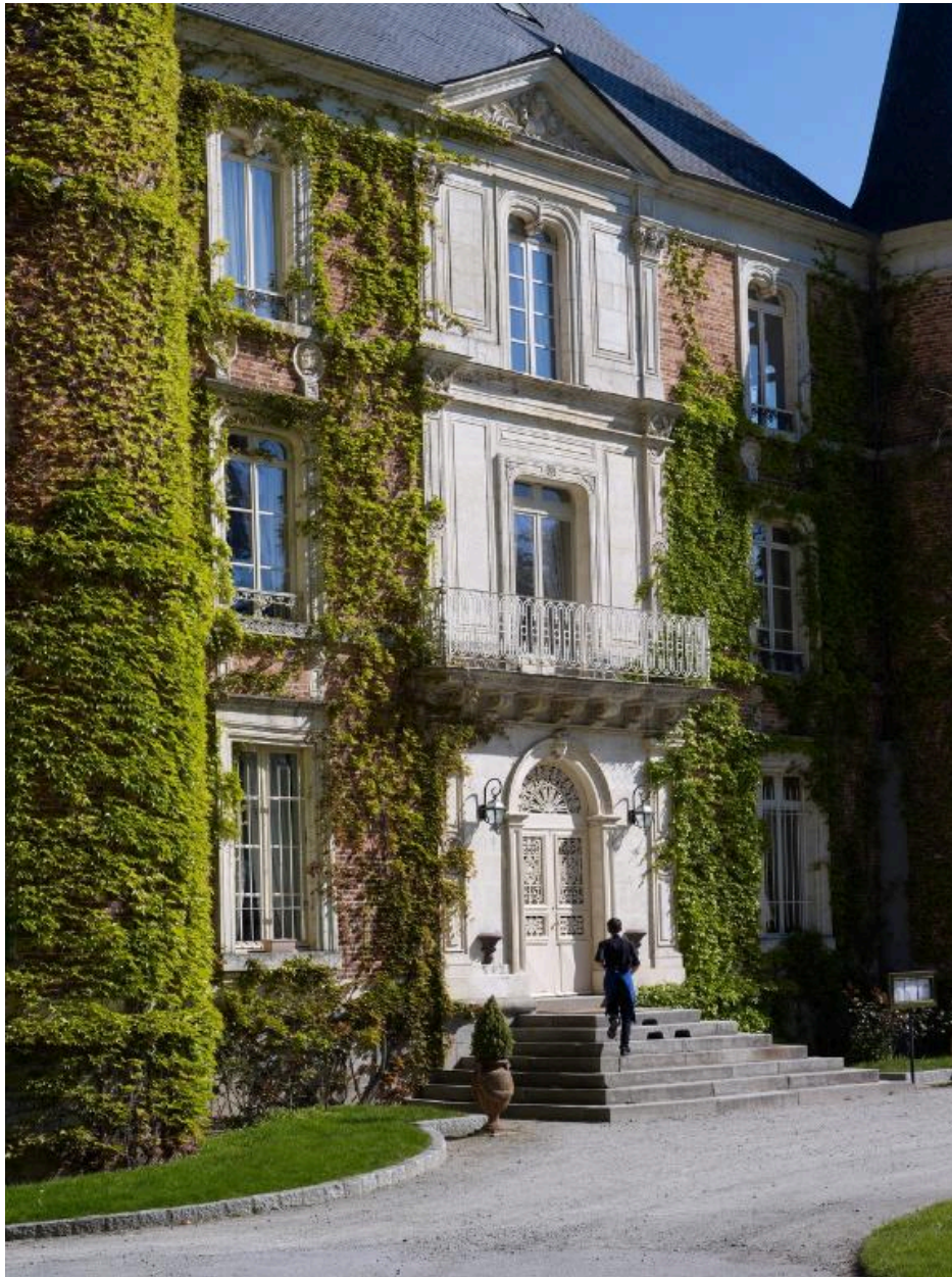
Vue biaise de la façade sud
