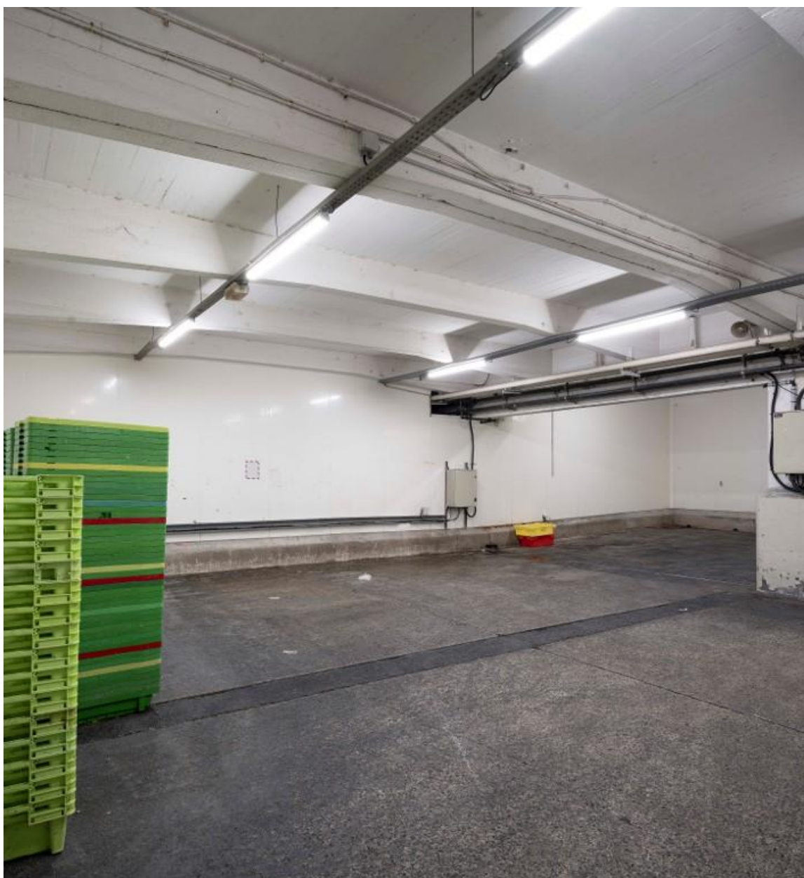
Poutres coffrage béton
