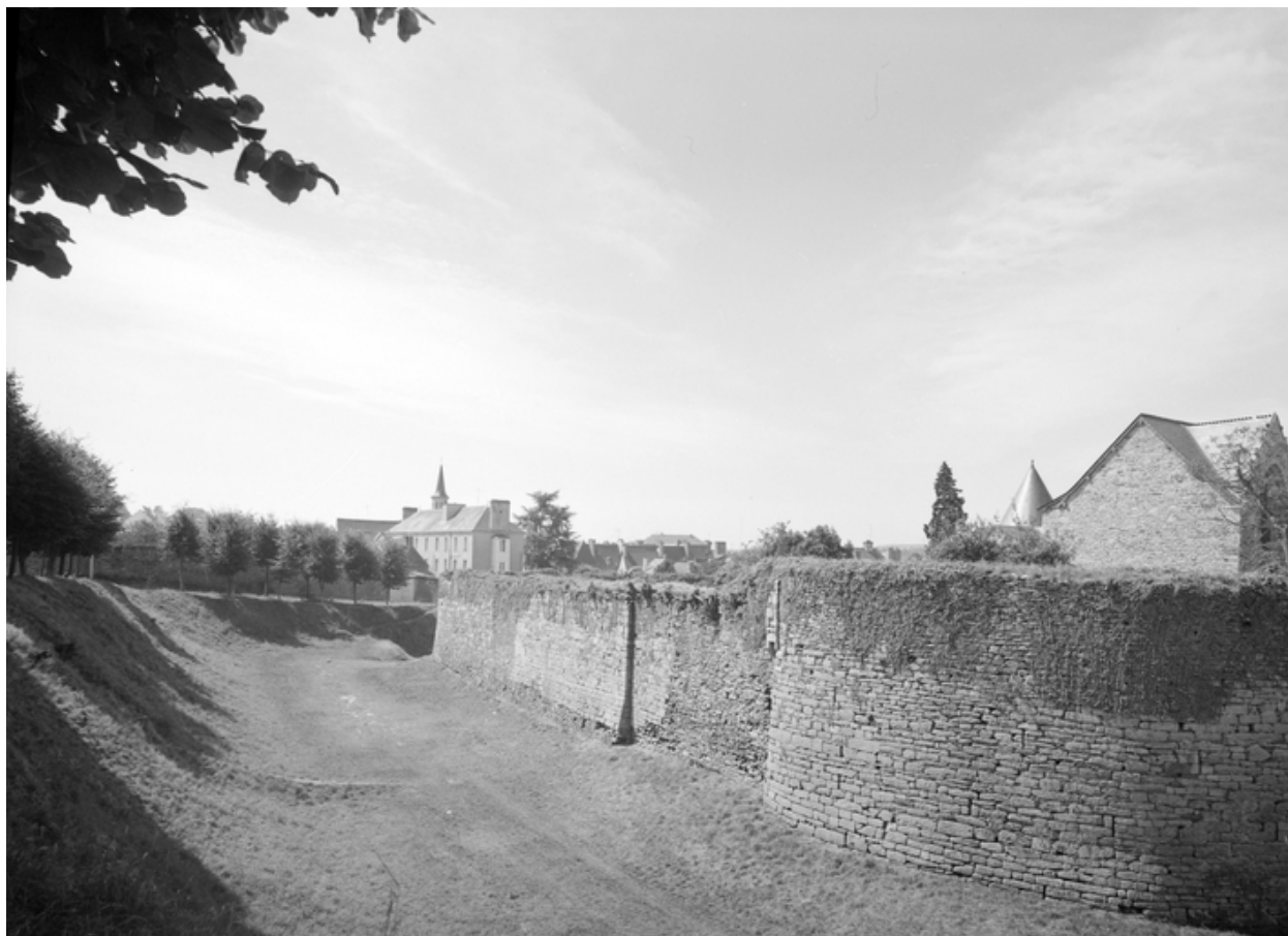
Chemise est et fossé, vue générale nord-est.
