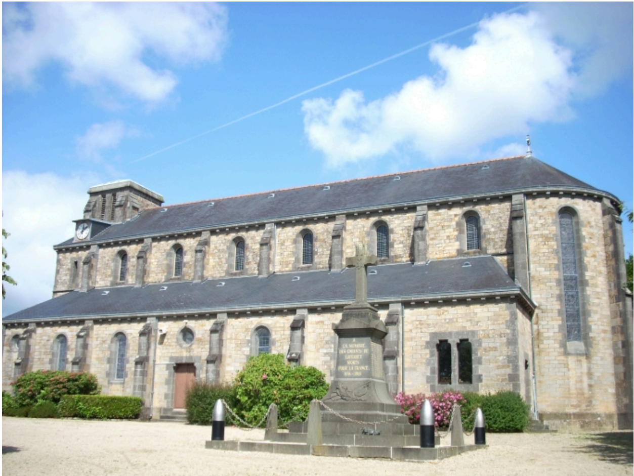
Loperhet, église paroissiale : vue générale sud-est
