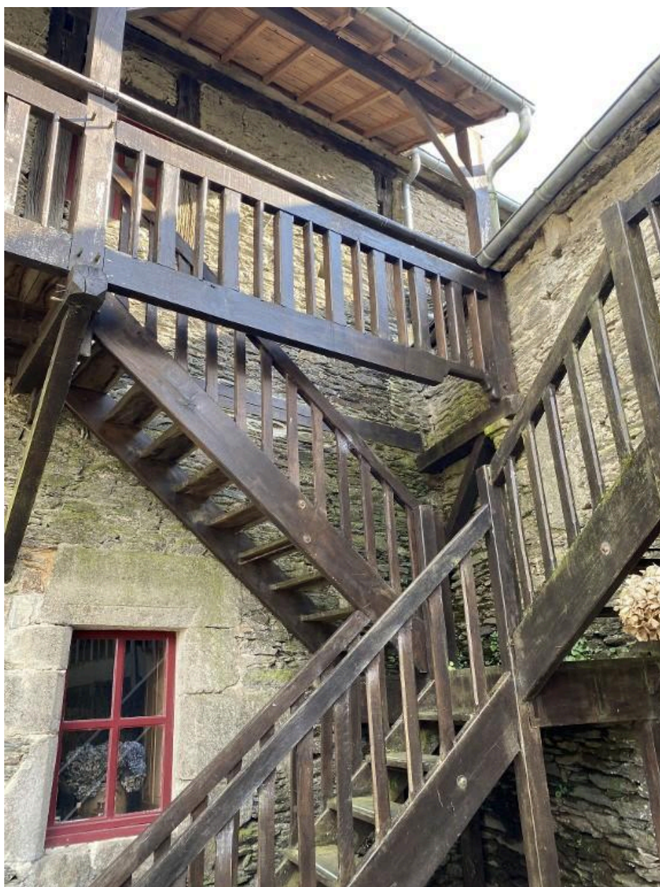
Escalier extérieur, vue générale
