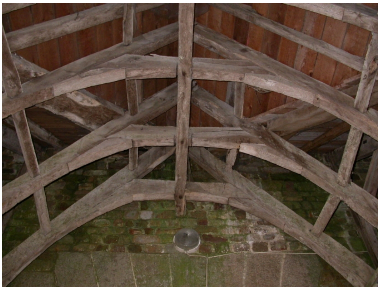
Charpente du porche
