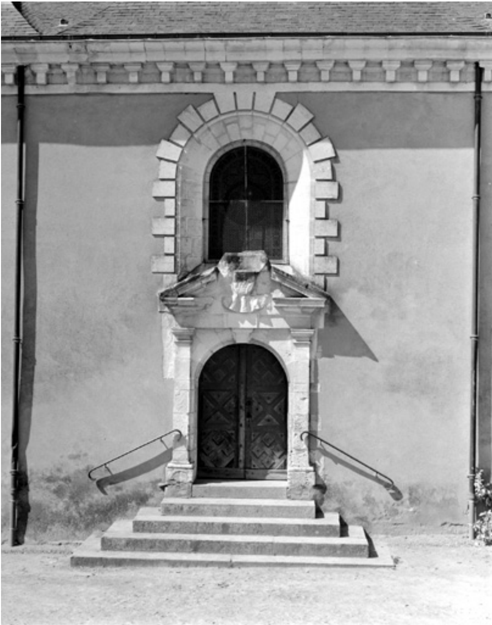
Elevation sud, porte
