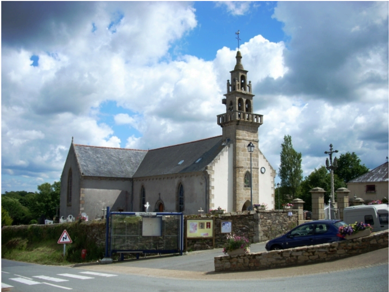
Tréglonou, église paroissiale : vue générale nord-ouest
