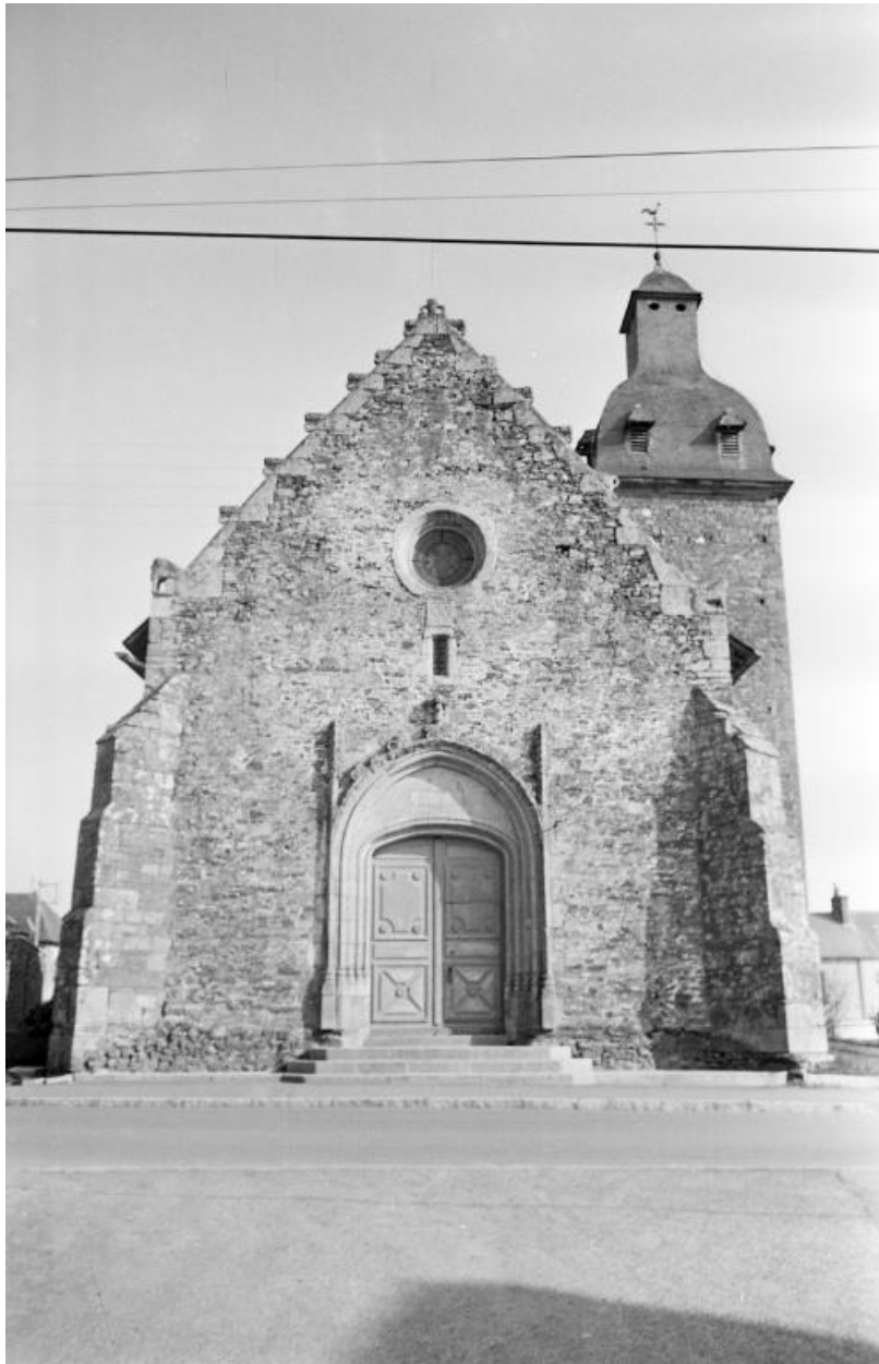
Pignon ouest, état en 1972
