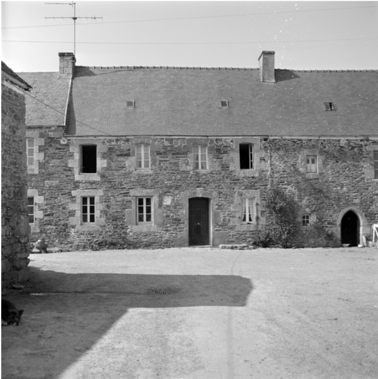
Maison, logis B : façade sud, vue générale (état en 1974).
