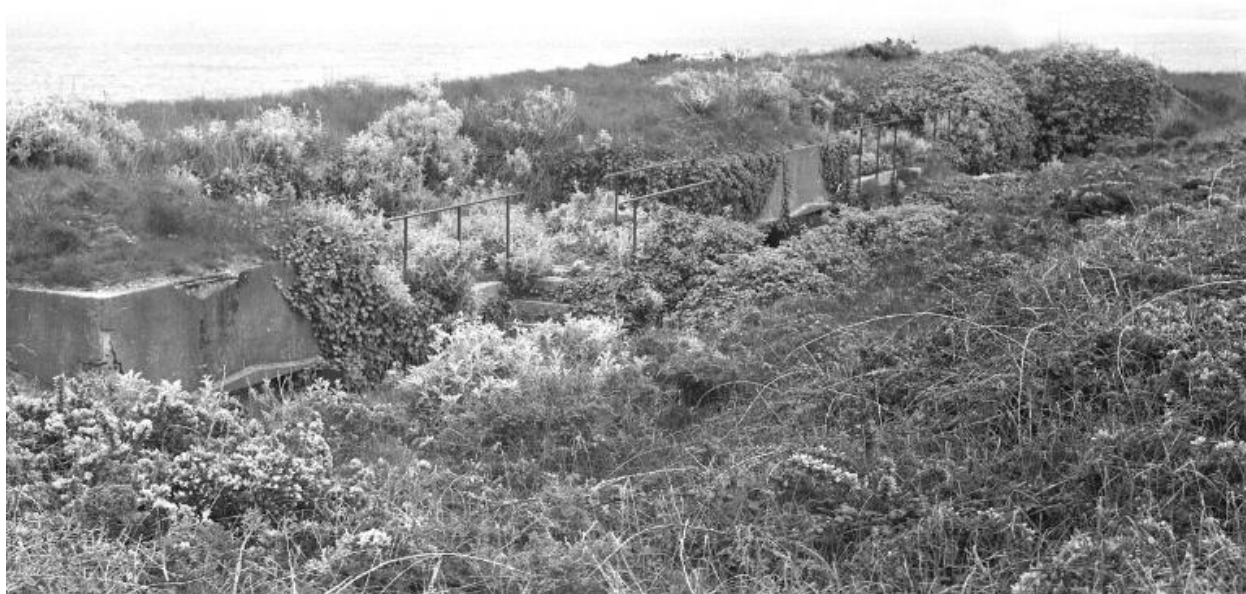
Batterie, vue générale
