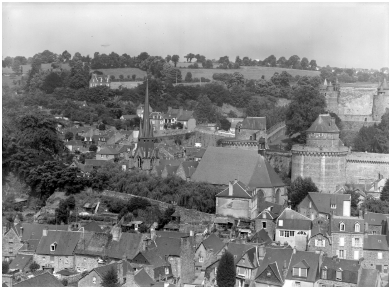
Vue de situation prise du sud-est.
