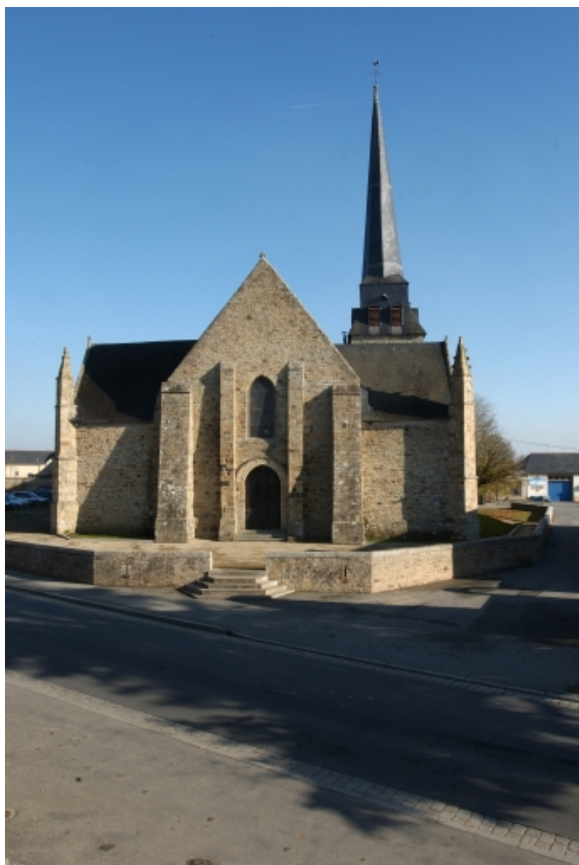
Vue générale de la façade ouest
