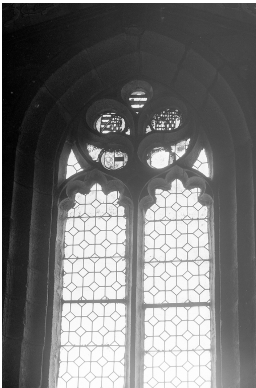
Croisillon occidental nord, fenêtre du mur nord (5) : détail du remplage et des armoiries
