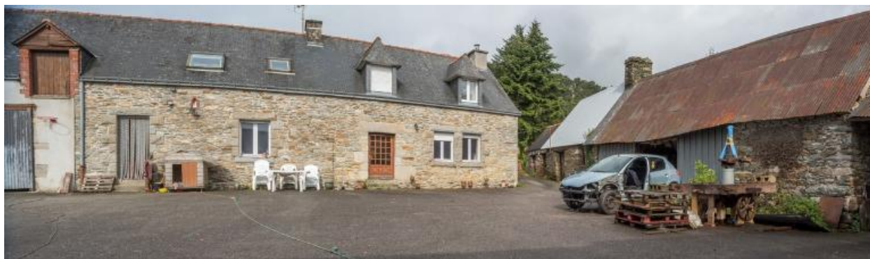
Longère et dépendances. Vue générale sud-ouest
