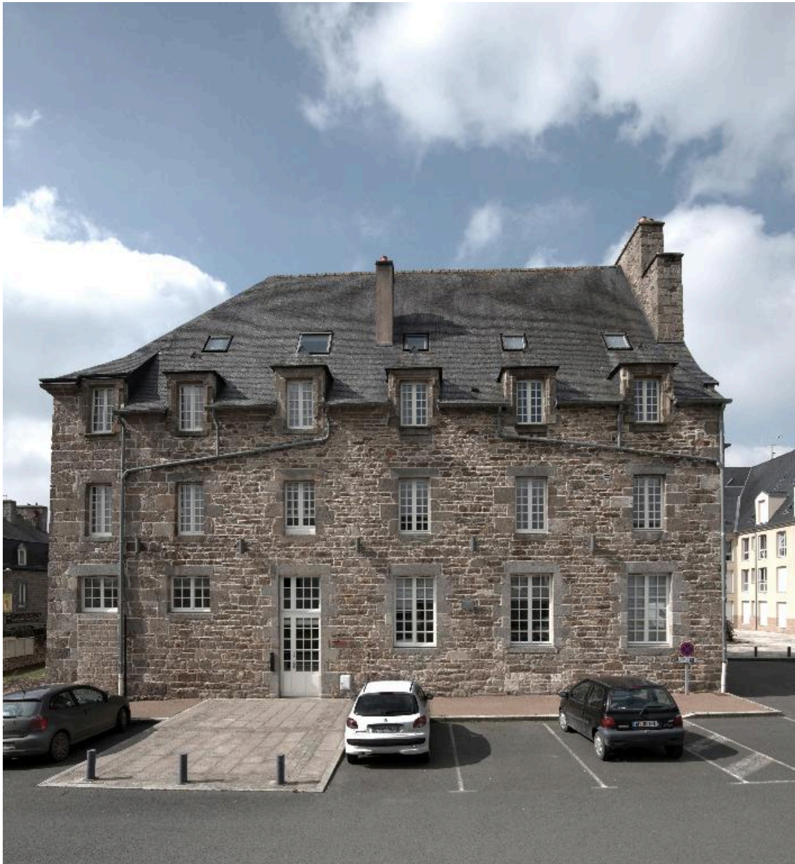
Vue de la façade est du bâtiment
