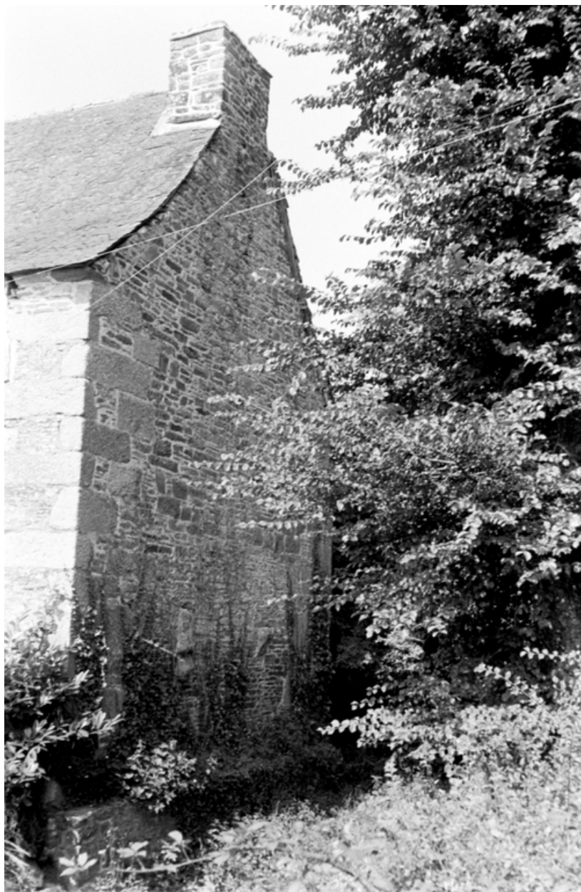
Angle sud est : détail du chaînage d'angle
