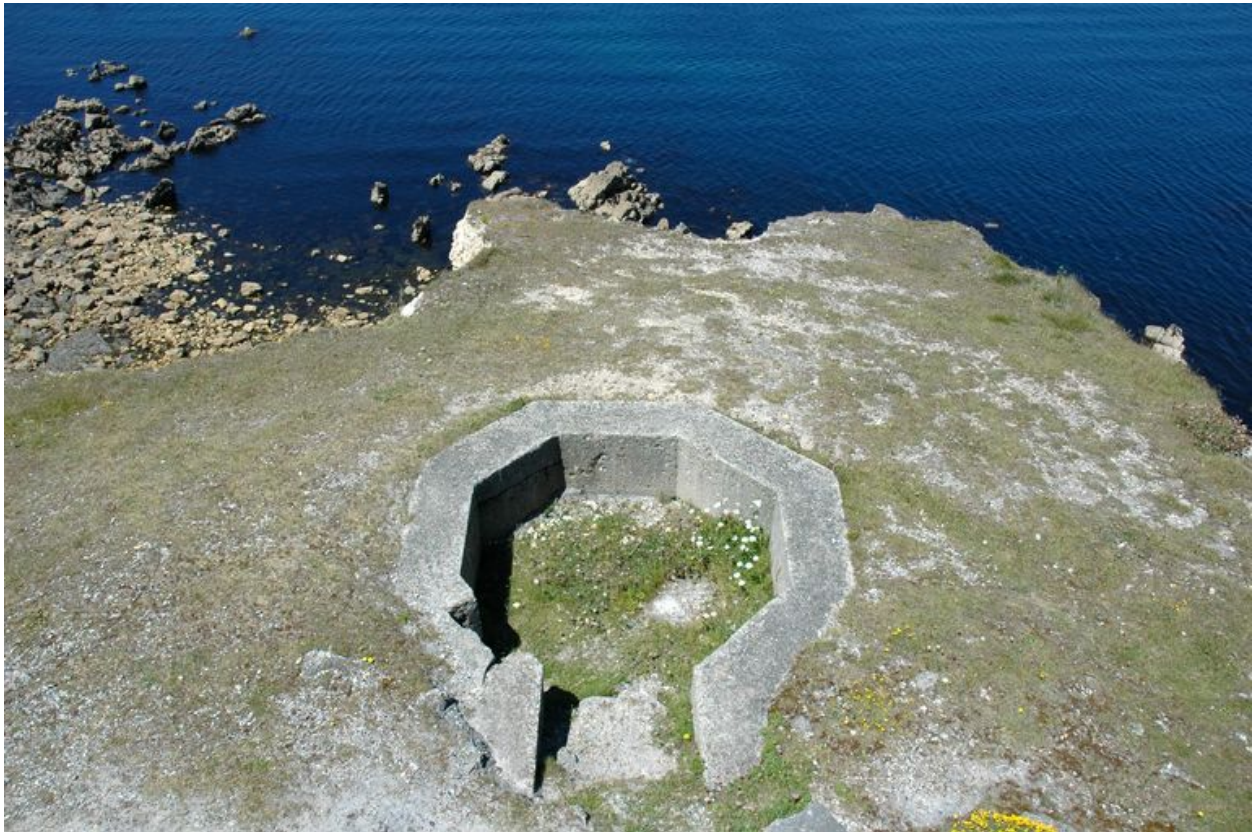
Vue de la cuve du télémètre situé à côté du bunker - poste de direction de tir de type 636a (état en 2005)
