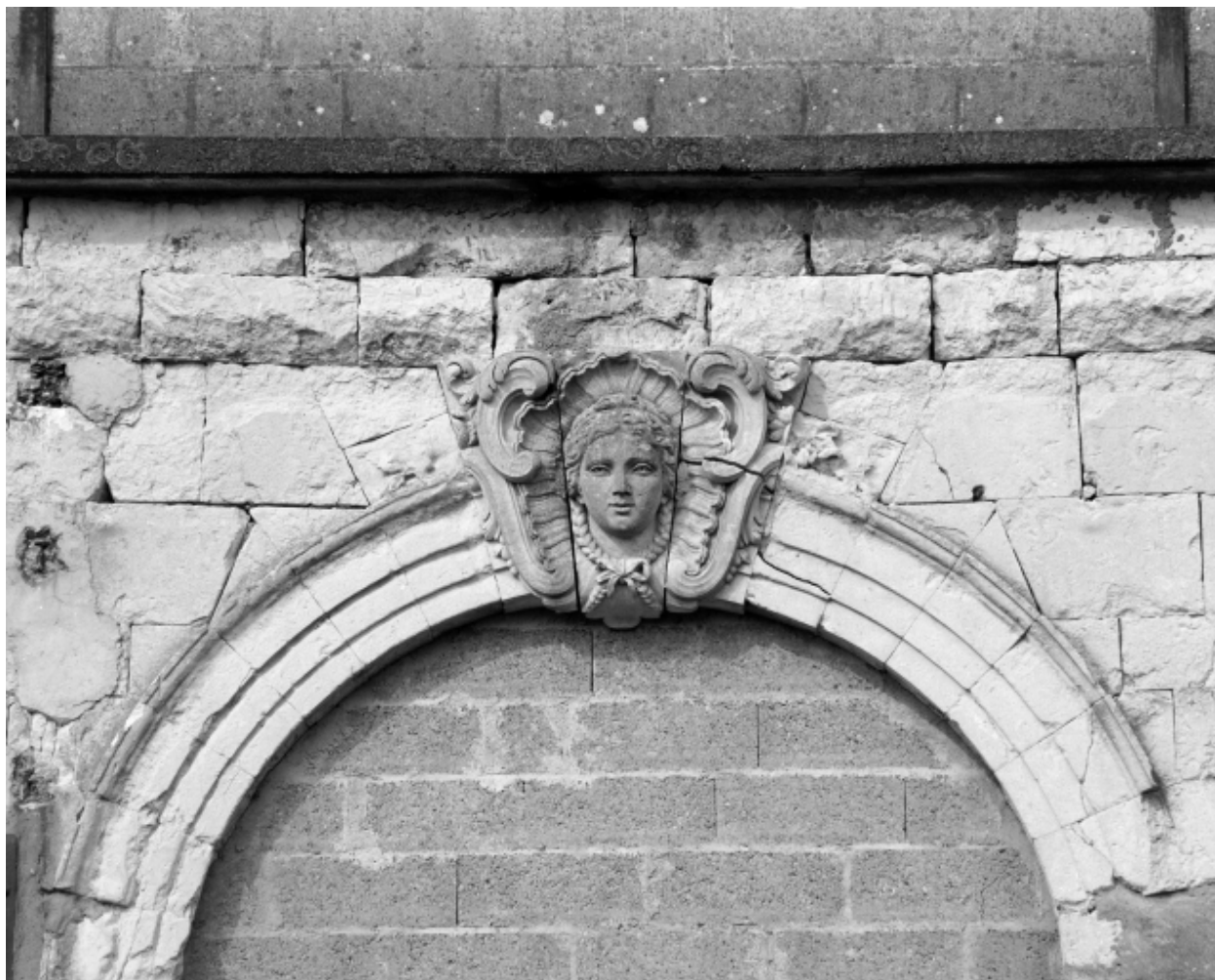
Façade sud ; avant corps, détail
